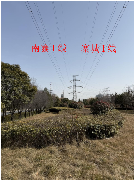
图 3.1-1 利旧段南寨 I 线线路现状
