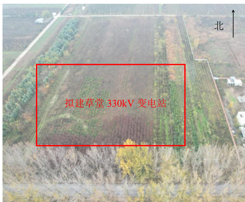
图 3.1-1 拟建草堂 330kV 变电站站址现状照片
