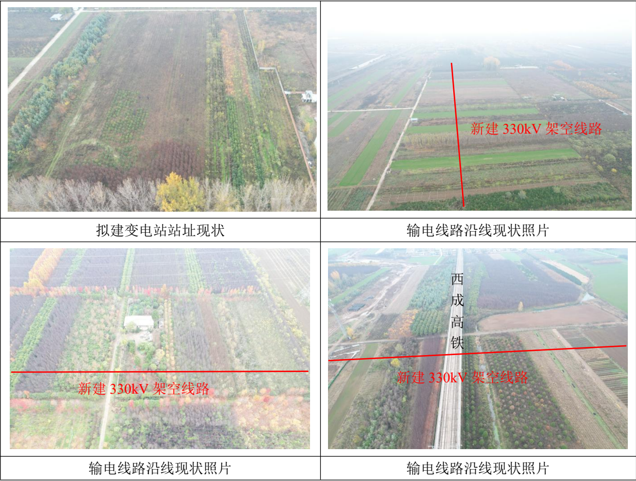
图 4.5-1 项目所在区域现状照片
