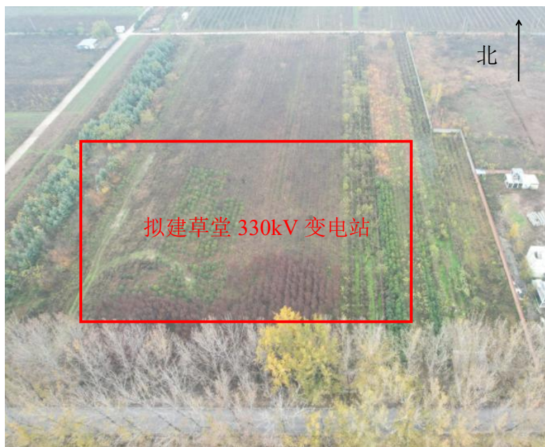
图 3.1-1 拟建草堂 330kV 变电站站址现状照片
