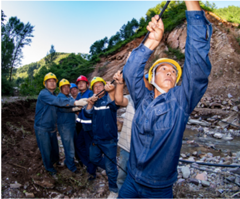
国网商洛供电公司员工在洛南暴雨洪涝灾害受灾地区进行抢修作业
