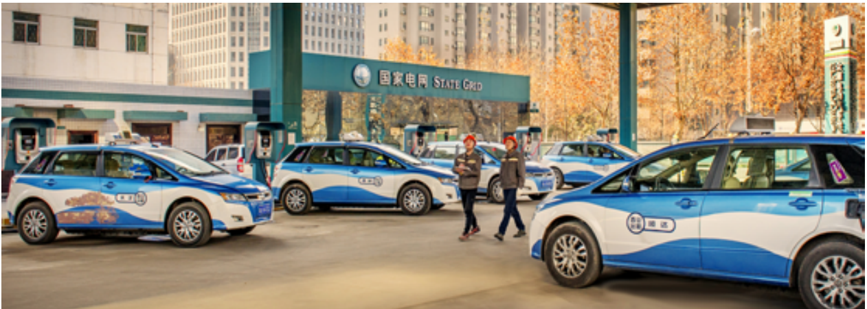
国网西安供电公司工作人员对电动汽车充电站设备开展巡查
