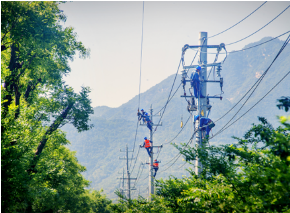
农村电网升级改造现场
