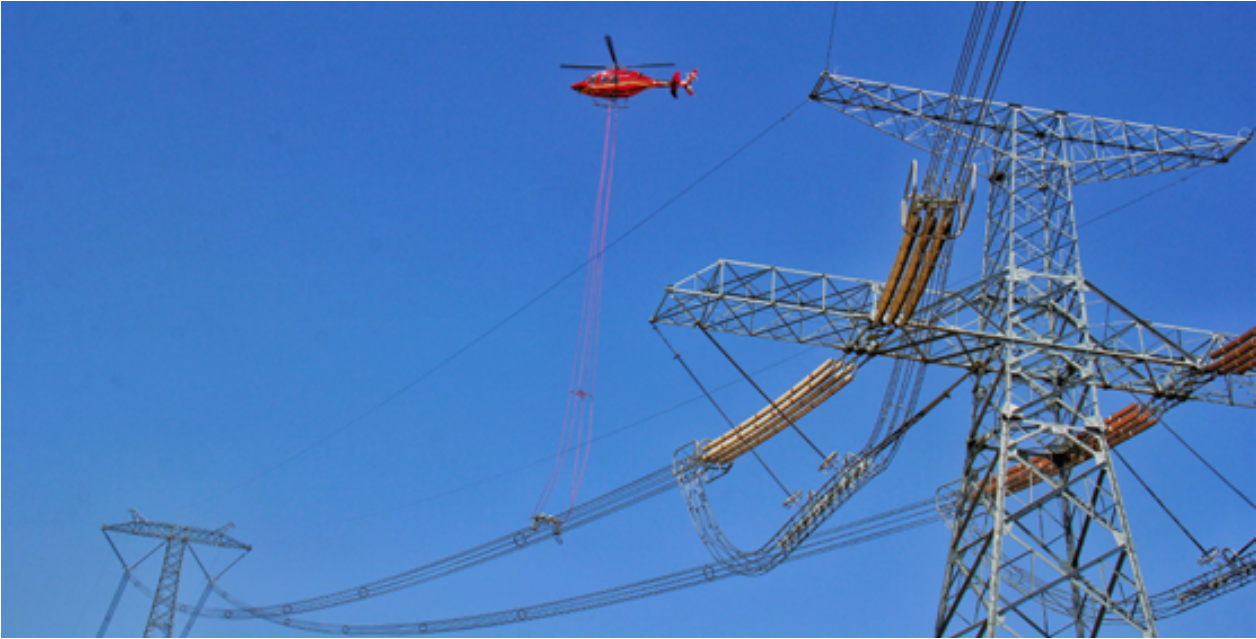
采用直升机吊索法和吊篮法完成陕西电网首例直升机带电作业
