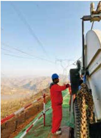
跨越黄河施工现场
